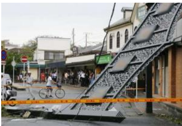
■看板の基礎から損傷し、歩道や車道に倒壊した事例
