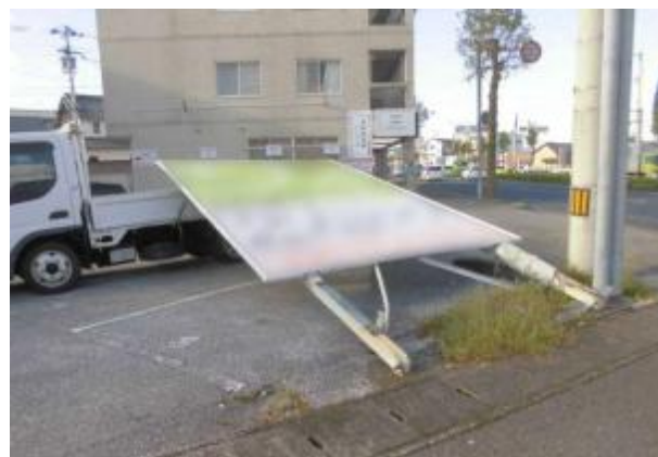
■看板の倒壊により一般の車にも被害があった事例
